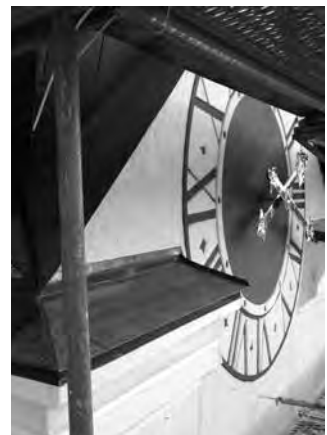
Bild 4: Bereits fertig sind auch die Malerarbeiten am Turm
